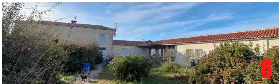
4-5-6 Changement des toitures : logements et locaux communaux
